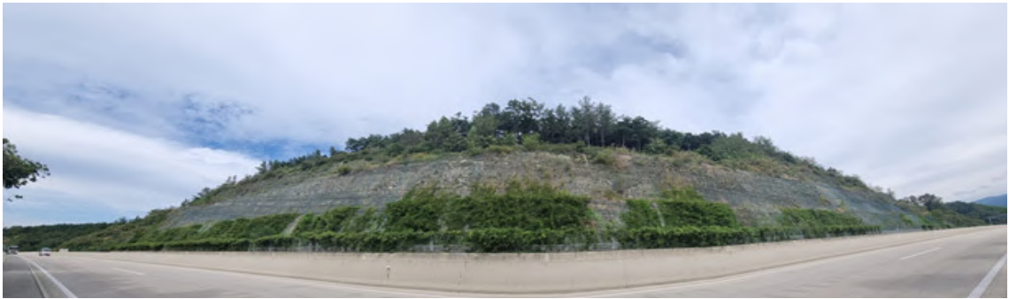
상주절토 10 (관리이정 15.314~15.514km / 2공구 STA.7+920~8+120)
