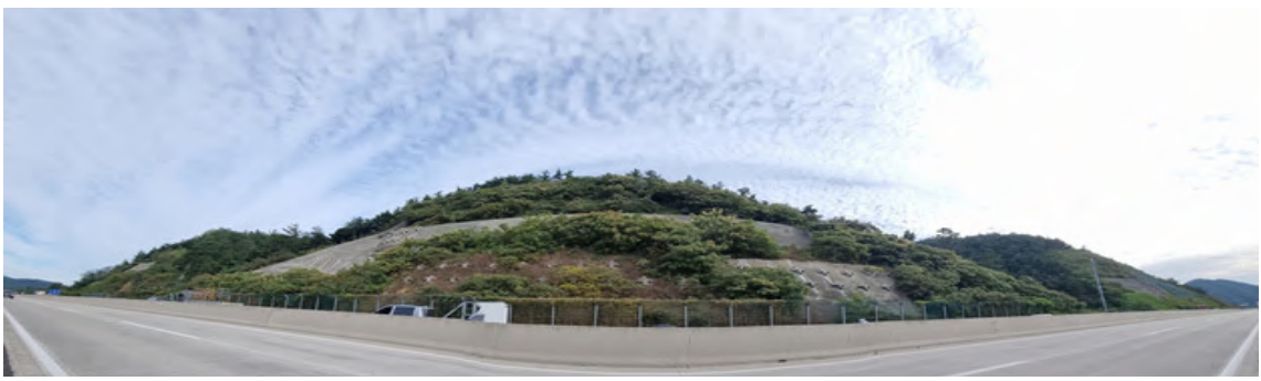
상주절토 43 (관리이정 58.858~59.078km / 7공구 STA.3+300~+3.520)
