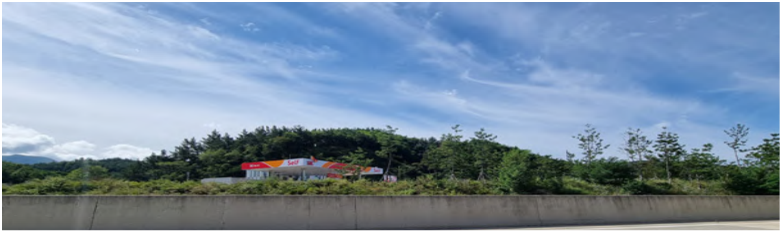
상주절토 42 (관리이정 58.638~58.798km / 7공구 STA.3+080~3+240)
