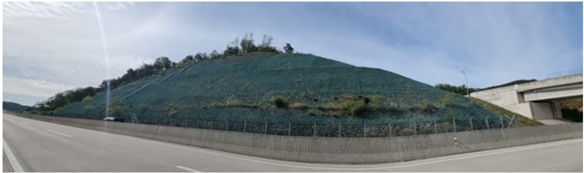
영천절토 58 (관리이정 0.920~1.340km / 8공구 화산JCT RA우측 STA.0+920~1+340)
