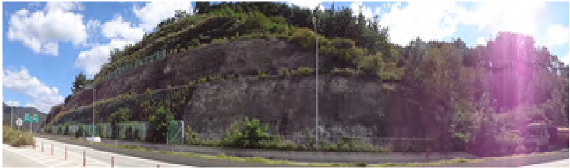
영천절토 34 (관리이정 1.890~2.150km / 5공구 군위R-A(중앙)STA.1+890~2+150)
