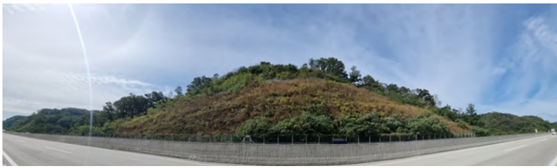
영천절토 55 (관리이정 74.758~74.938km / 8공구 STA.9+400~9+580)
