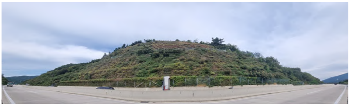
상주절토 15 (관리이정 18.104~18.334km / 3공구 STA.2+090~2+320)
