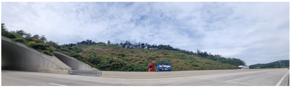
상주절토 03 (관리이정 3.540~3.830km / 1공구 STA.3+540~3+830)
