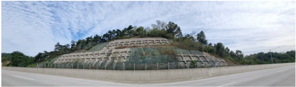
상주절토 50 (관리이정 71.71.478~71.718km / 8공구 STA.6+120~6+360)
