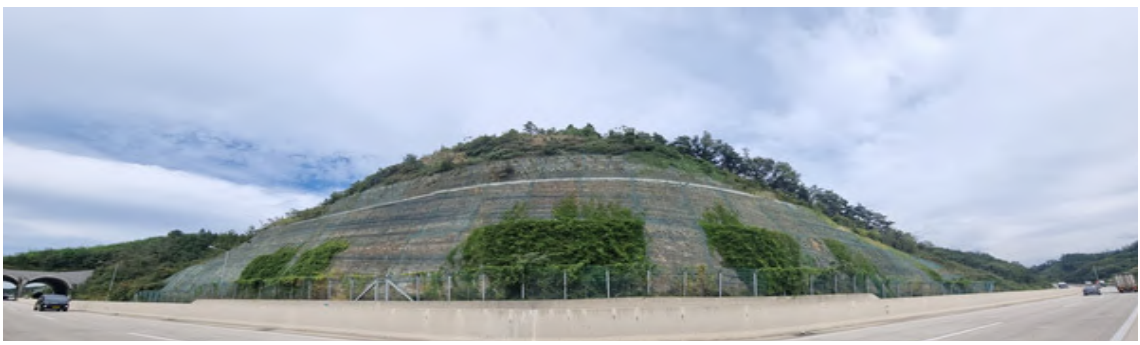
상주절토 11 (관리이정 15.894~16.014km / 2공구 STA.8+500~8+620)
