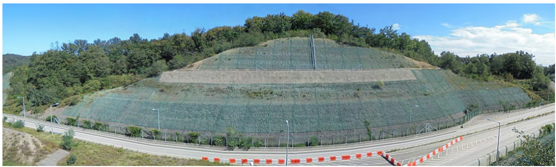
영천절토 59 (관리이정 1.600~1.723km / 8공구 화산JCT RA좌측 STA.1+600~1+723)
