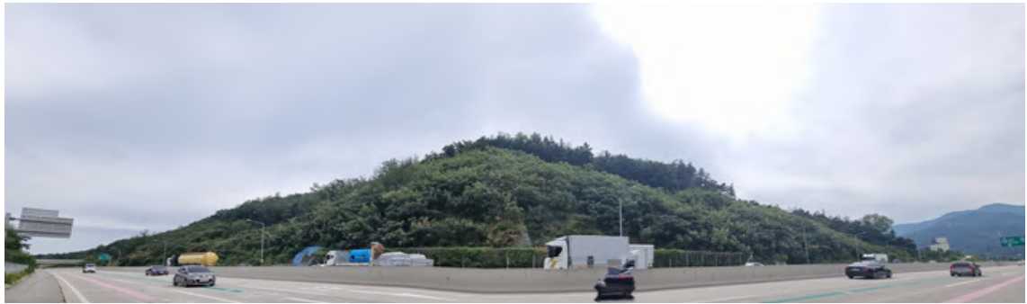
상주절토 02 (관리이정 2.240~2.510km / 1공구 STA.2+240~2+510)
