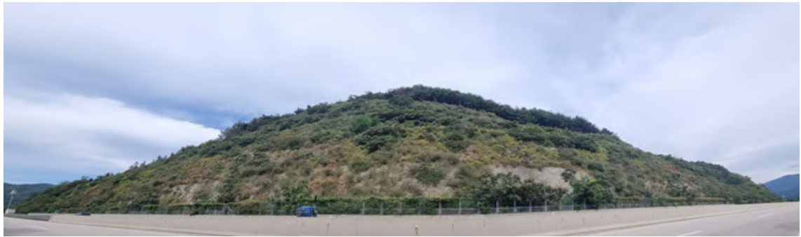
상주절토 14 (관리이정 17.304~17.504km / 3공구 STA.1+290~1+490)
