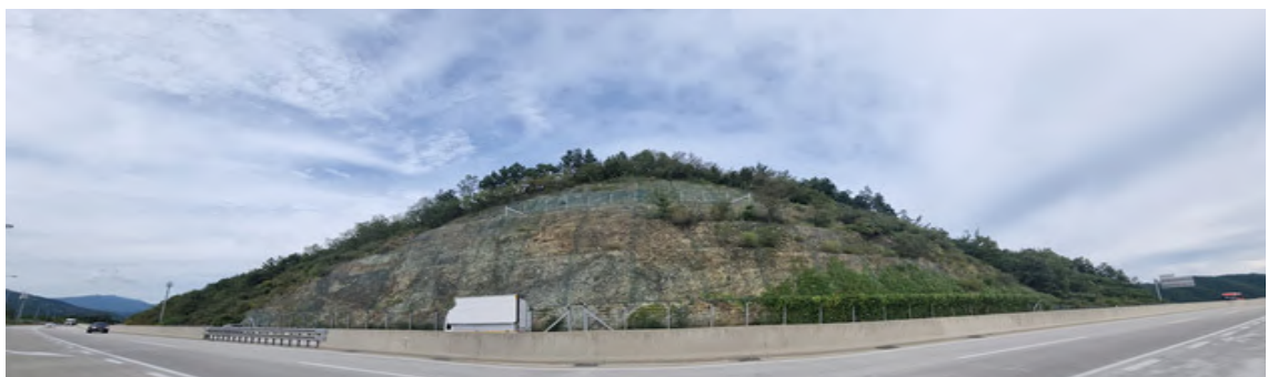
상주절토24 (관리이정 30.413~30.588km / 4공구 STA.1+430~1+605)
